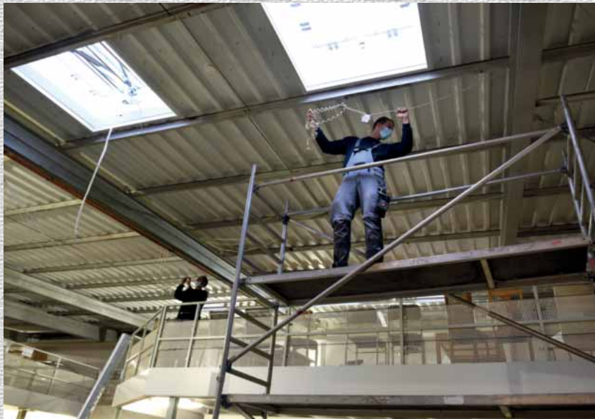
Meilenstein für das Caritas-Kaufhaus Neuss: Eine neue Hallendecke samt neuer Beleuchtung sorgt für eine schönere Optik und eine bessere Energiebilanz.
