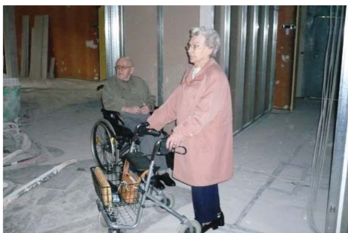
Links: Prüfender Blick - der Heimbeirat besichtigt während der Umbauarbeiten die Baustelle im Caritashaus Hildegundis von Meer.
