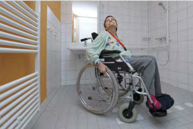
Schön und schön groß: In den neuen barrierefreien Badezimmern im Theresienheim gibt es reichlich Platz.
